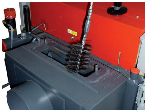
Pulizia della cassa fumi e coni canna fumaria con una spazzola metallica - coperchio superiore.
