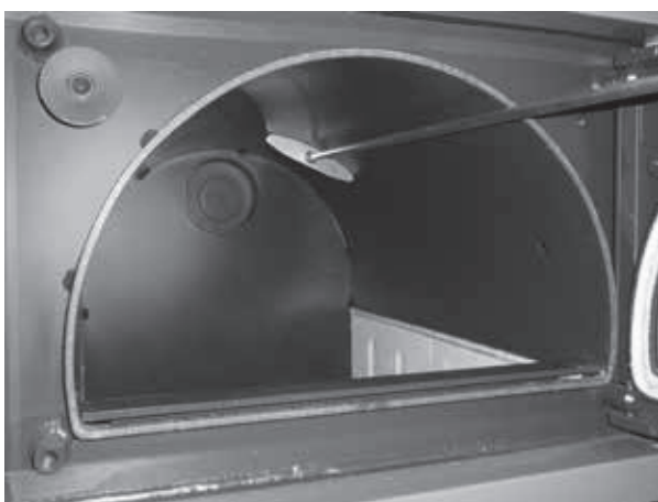
Pulizia della camera di caricamento superiore con attizzatoio
